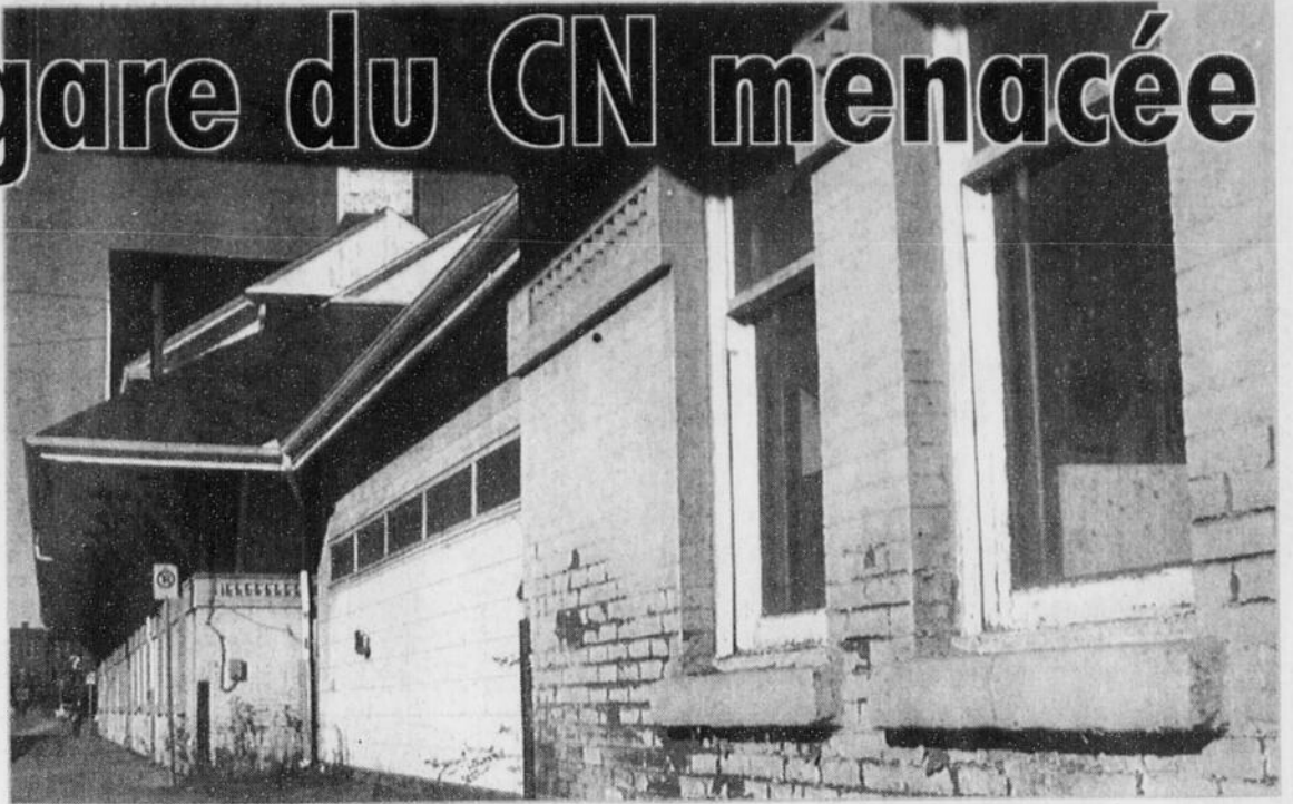
La gare du Canadien National, rue Dépôt, risque d'être démolie si personne ne démontre son intérêt à l'acquérir.
