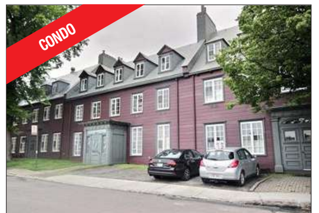
QUÉBEC. Construite en 1727. Possédez une partie d'histoire au cœur du Vieux-Québec. 395 000 $
