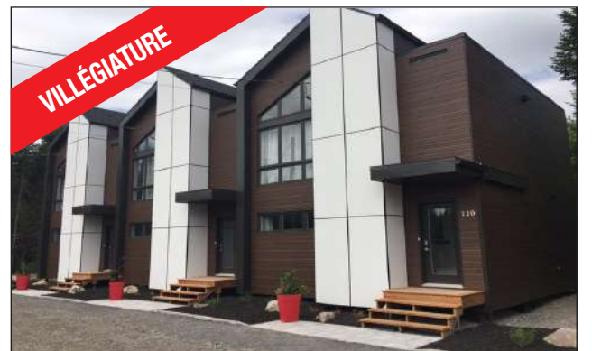
PONT-ROUGE. Superbe villa en rangée de 1 200 pc sur 2 niveaux. Accès à la piscine. 254 000 $
