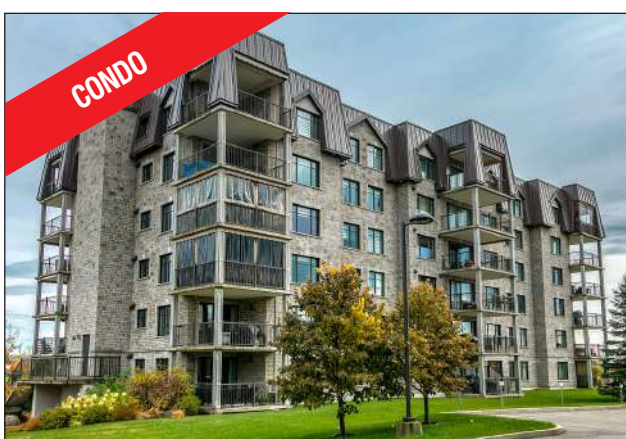
CHARLESBOURG. Domaine de la faune sur le Golf. Grand 3½ situé au rez-de-chaussée. 169 000 $
