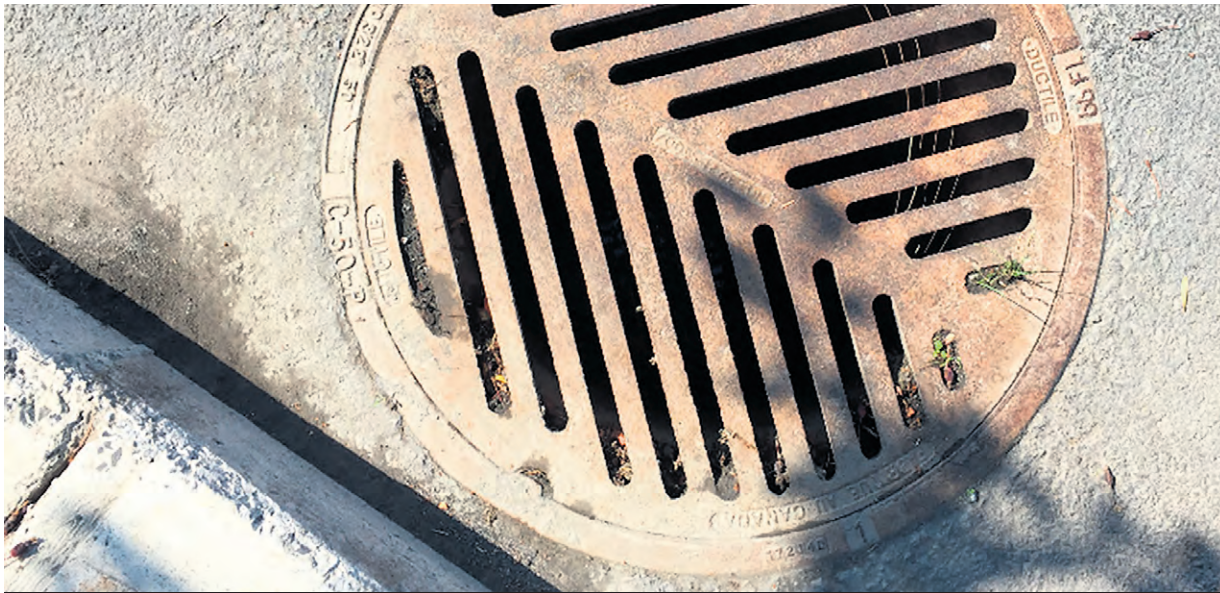
La vérification du raccordement au réseau d'égout commence sur le territoire de la Ville de Terrebonne.
