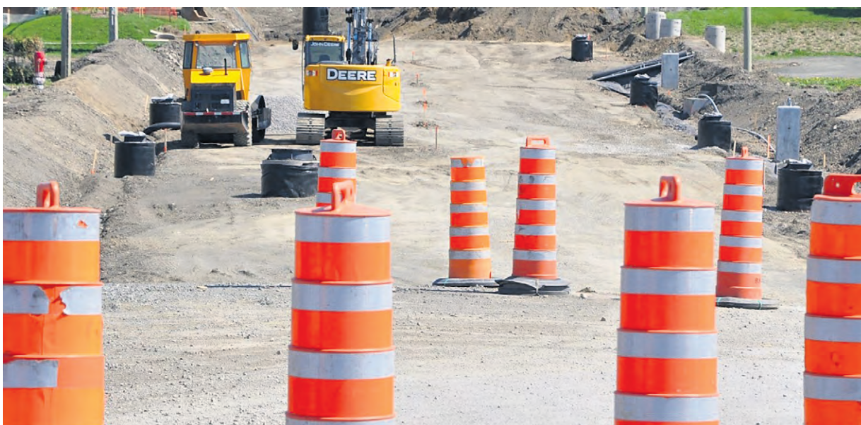
Dès septembre, des travaux de remplacement d'un ponceau marqueront le début d'un chantier majeur qui sera en cours jusqu'en 2026 sur le chemin des Anglais.
