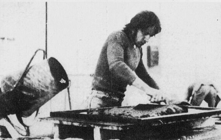
Un des travailleurs de Pan-O-Bloc Inc. fabrique un panneau en étalant dans un moule la pâte composée de tourbe et de ciment.
