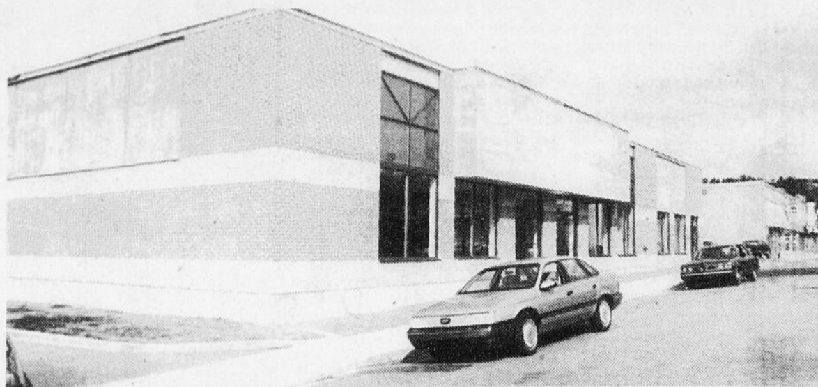
EDIFICE COMMERCIAL - Le centre-ville de Ville de La Baie compte maintenant un édifice
