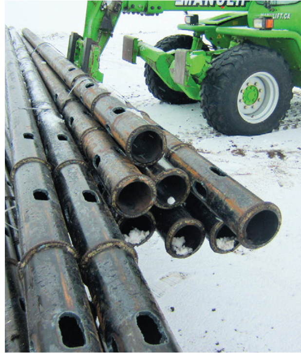
Figure 10 : Livraison des pieux au chantier
