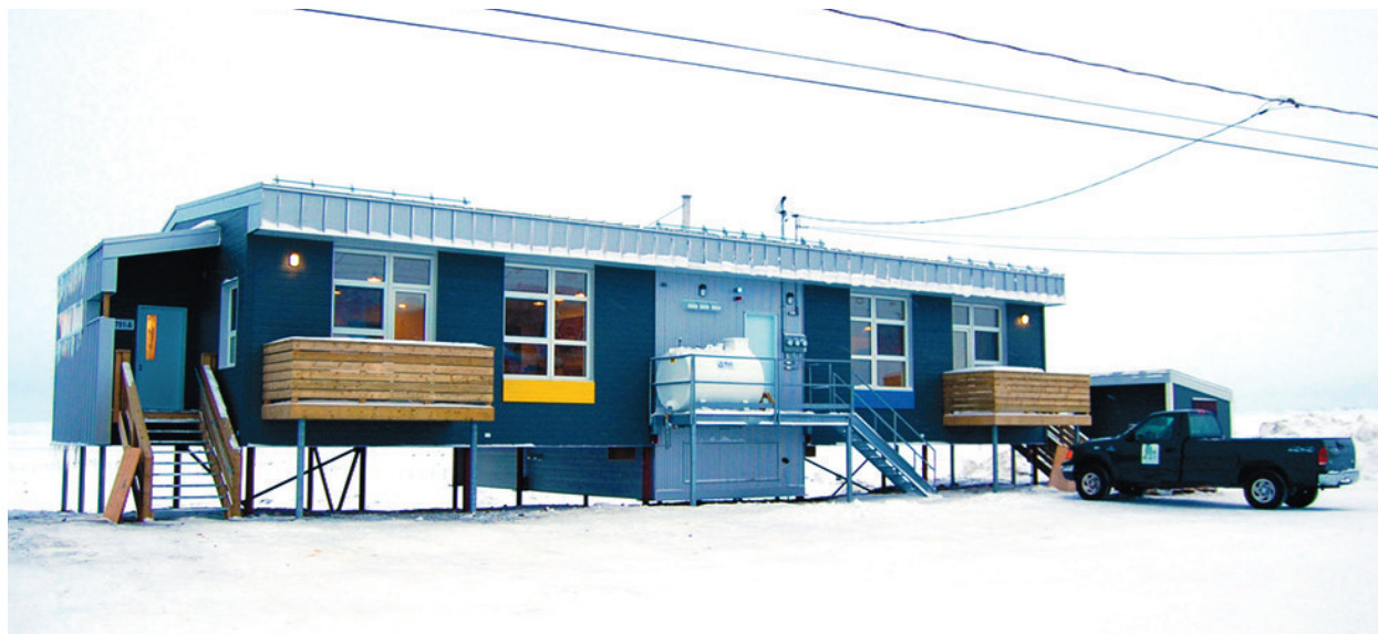
Figure 4 : Façade sud du prototype
