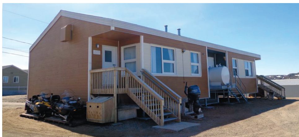
Figure 5 : Façade d'un J2.2 construit par la Société Makivik
