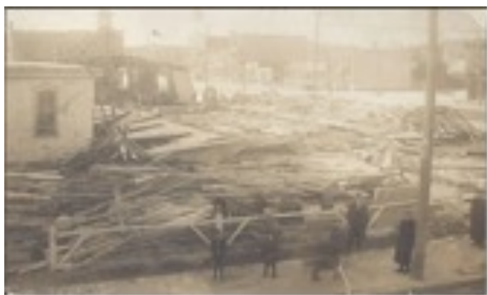
Démolition de la chapelle de bois - mars 1915 [12]
