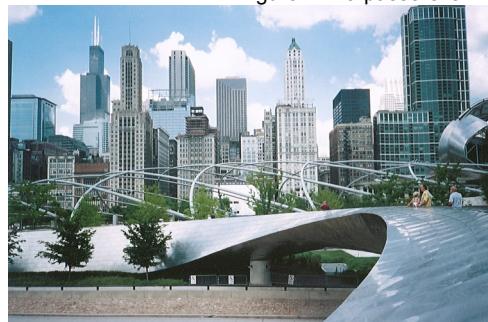
Figure 4 : La passerelle BP
