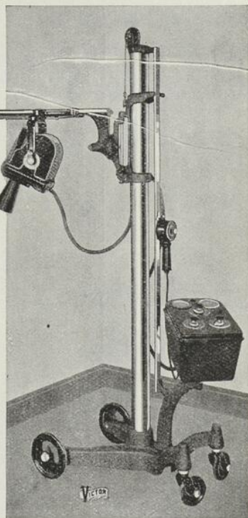
L'ampoule à rayons X et le transformateur qui l'alimente sont tous deux immergés dans l'huile que renferme un baquet métallique. Pas de fuites possibles. Le "bloc" peut prendre toutes les positions. La haute tension est si complètement isolée que l'on peut, en plein fonctionnement, toucher n'importe quelle partie de l'appareil.
