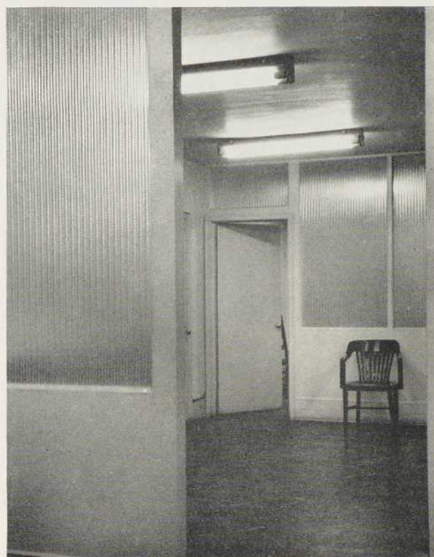
Cette photographie fait voir un cloisonnage en verre laminé ondulé Pilkington, dans le nouvel édifice Goulding, rue Victoria, à Toronto.
