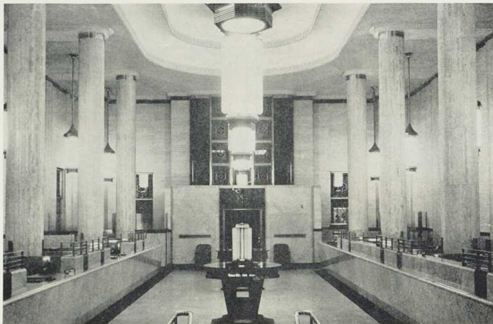
Vue intérieure de la nouvelle succursale de la BANQUE CANADIENNE NATIONALE rue Ste-Catherine ouest, Montréal, à la construction de laquelle notre maison a pris part
