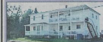
ST-HONORÉ: rue de l'Hôtel-de-Ville. Bloc appartements.
