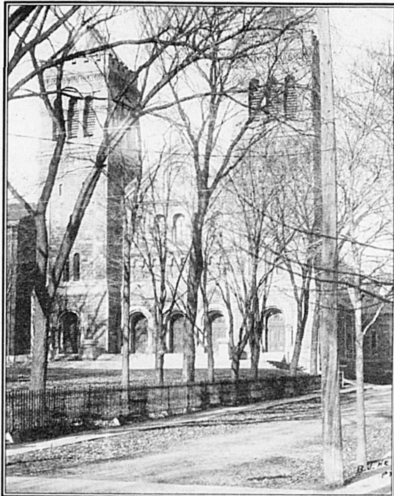
Vue d'ensemble de l'extérieur de la cathédrale avant les travaux de 1908. Photographie B. J. Hébert. (Collection des archives du Séminaire de Saint-Hyacinthe)
