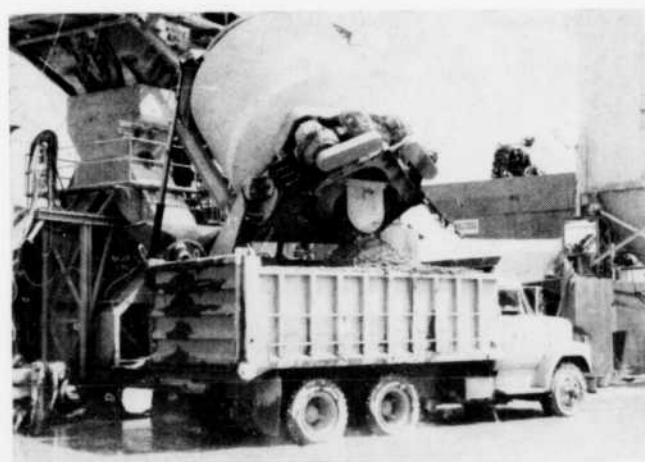
Photo 2 — Malaxage du béton
