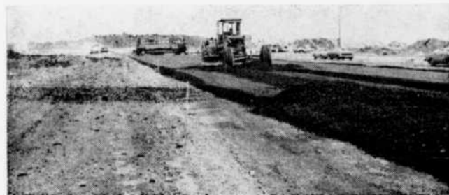
Photo 1 — Base stabilisée au ciment Portland
