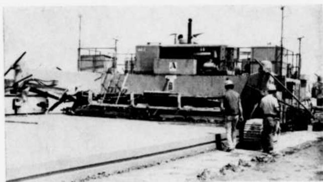
Photo 4 — Pose du béton
