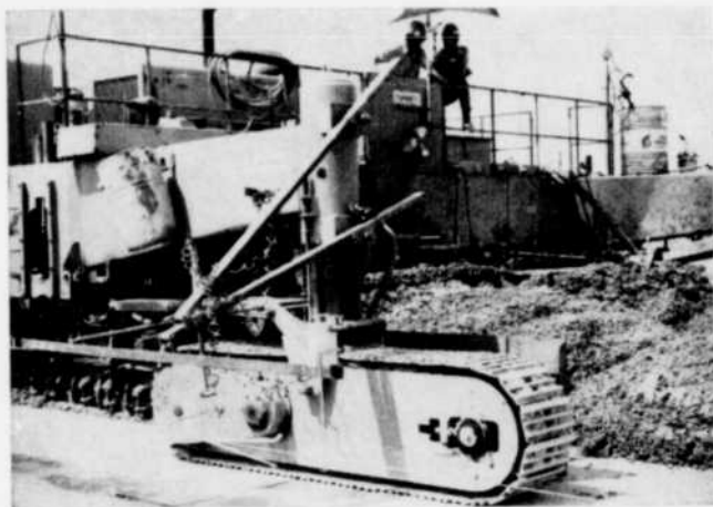
Photo 3 — Épandage du béton
