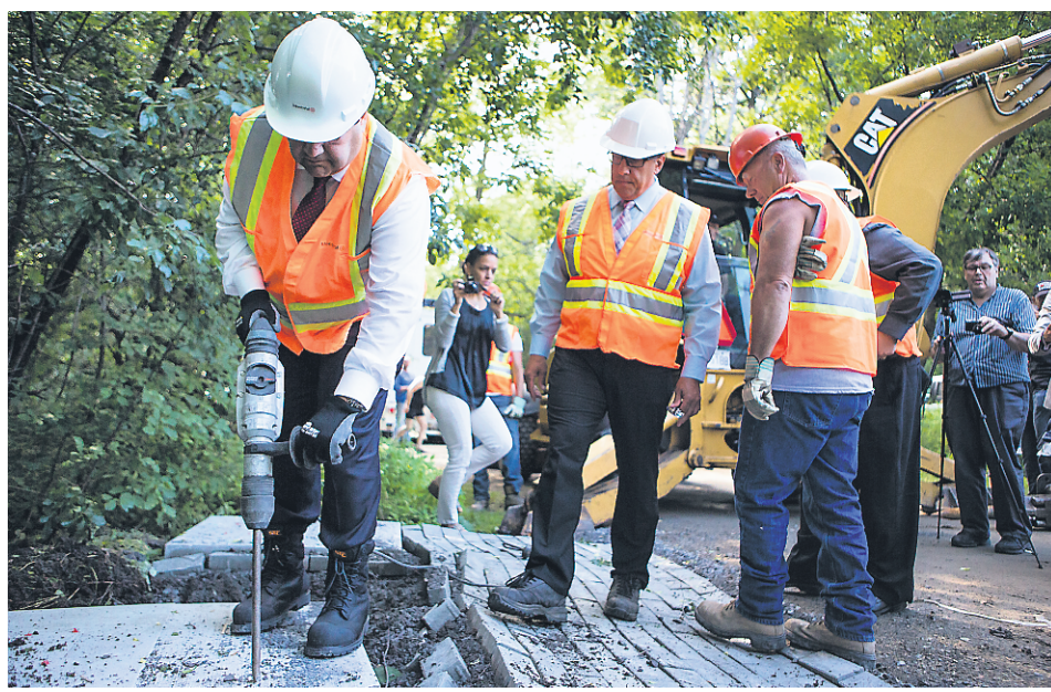
Le maire de Montréal, Denis Coderre, est passé à l'action, hier, et a détruit à grands coups de marteau-piqueur la dalle de béton coulée par Postes Canada.
