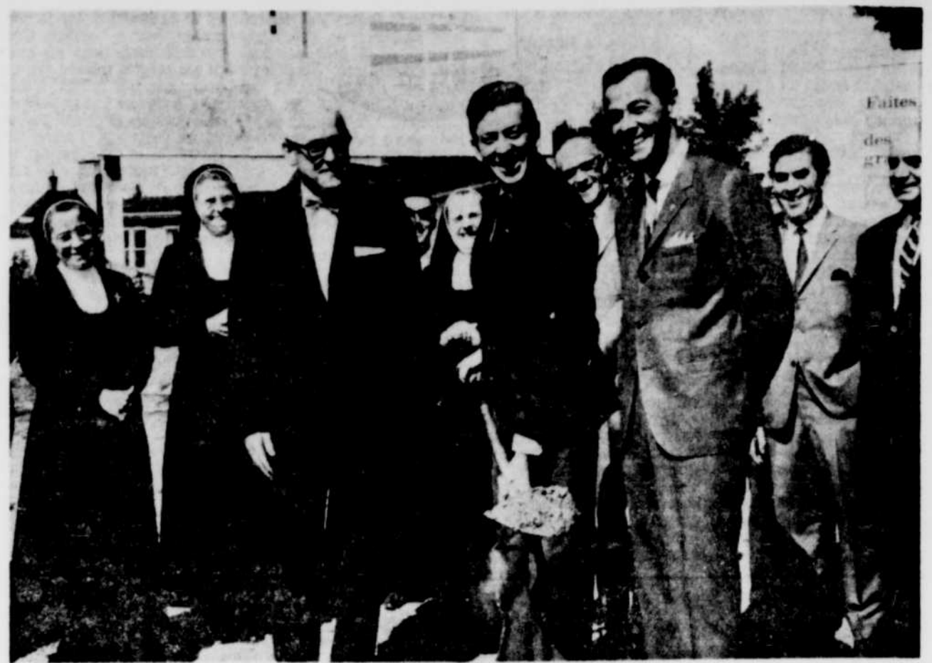
EN PRESENCE DE NOMBREUX INVITES, le député du comté de Lavolette, M. André Leduc lève la première pelletée de terre inaugurant les travaux du Foyer Grand'
