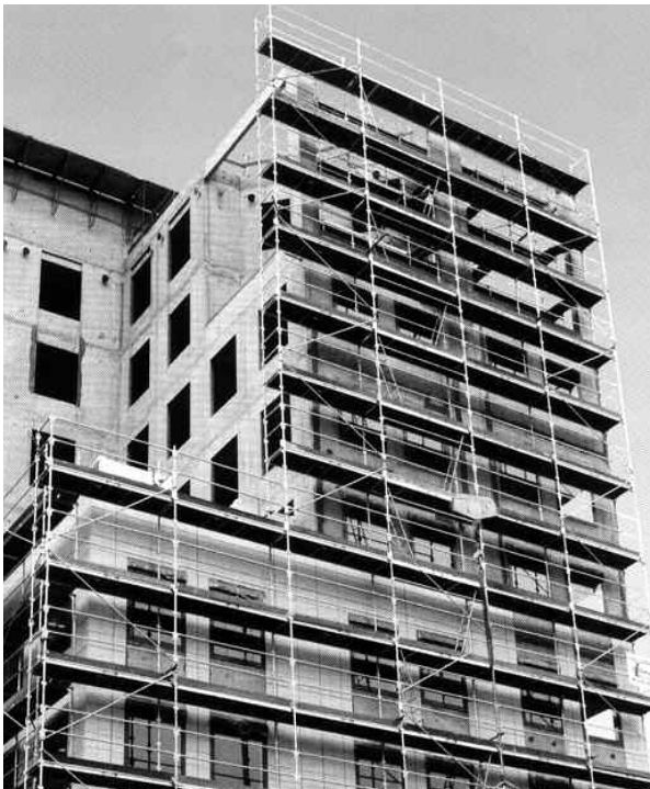
Figure 1.3.1 - Échafaudage sur cadres métalliques européens
