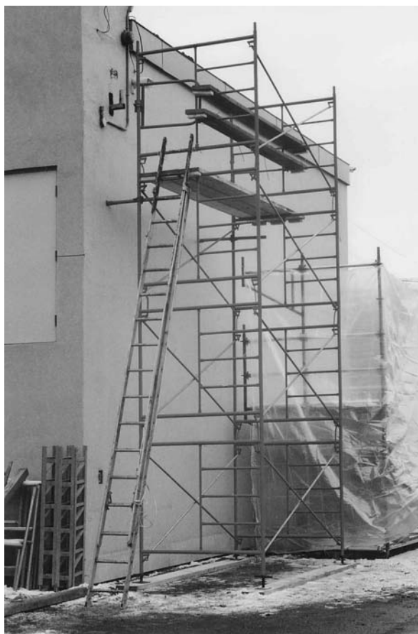
Figure 1.1.1 - Échafaudage sur cadres métalliques traditionnels
