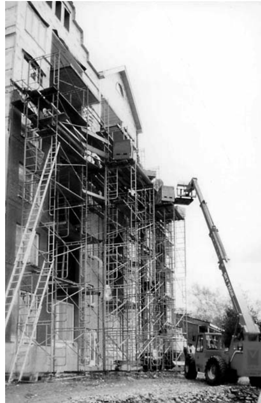
Figure 1.2.1 - Échafaudage sur cadres métalliques ouverts
