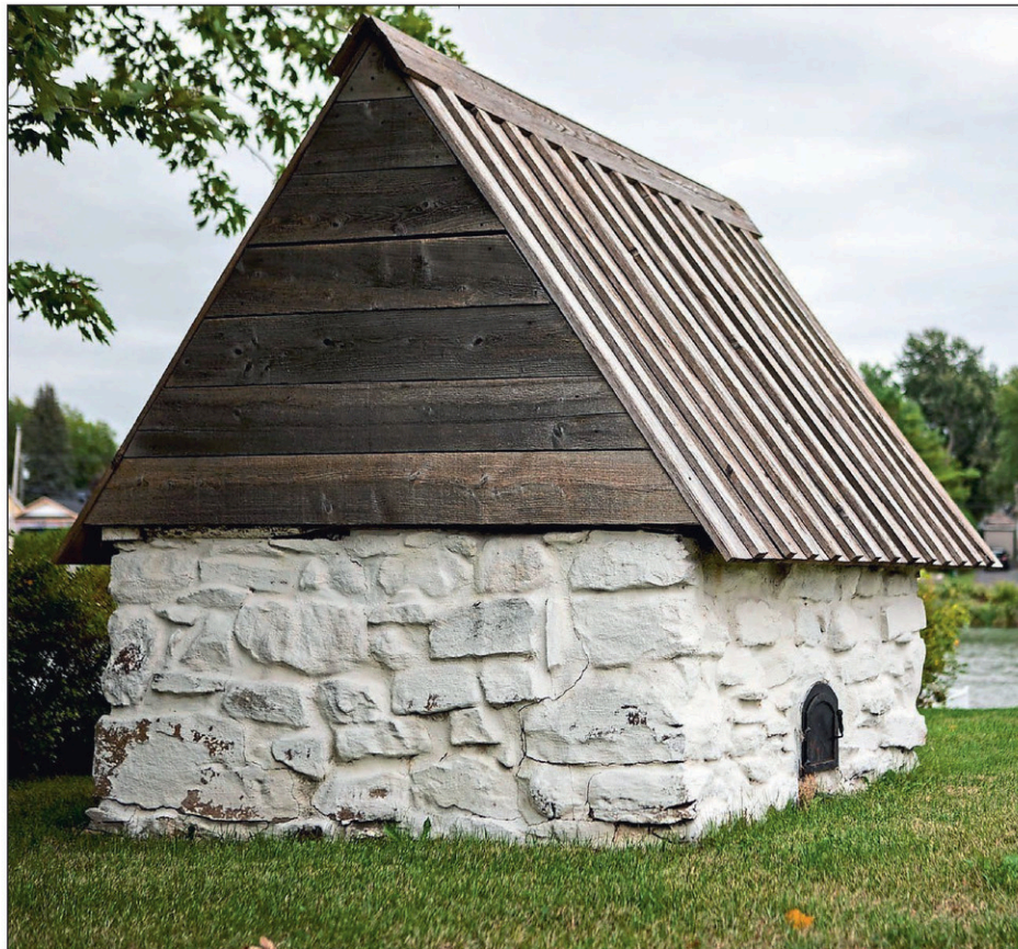
Remarquez sur le flanc droit du four à pain Dupuis la petite porte latérale en fonte. On déplore toutefois, aux environs des années 1980, le vol de sa gueule (portes en fonte) d'origine qui faisait face à l'île Sainte-Thérèse.
