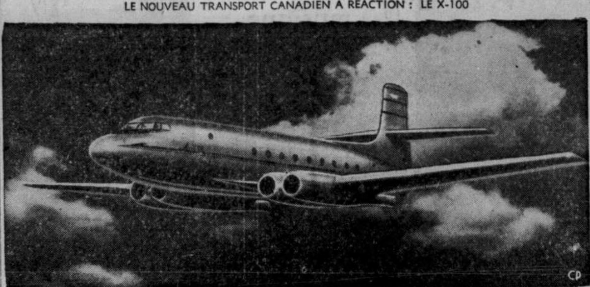
Voici quelques détails de la construction du nouvel avion canadien de transport propulsé par réaction, que la compagnie A.V. Roe construit en ce moment à Toronto. Capable de transporter 30 à 40 passagers à une vitesse de 400 milles à l'heure et une altitude de 30,000 pieds, il est muni par quatre moteurs Derwent à réaction, accouplés deux à deux et montés au centre des ailes. Destinés à des croisières à bref ou moyen rayon, cet appareil a une envergure de 90 pieds et une longueur de 82. On croit qu'il pourra subir ses premiers essais de vol l'an prochain. (Photo C.P.)
