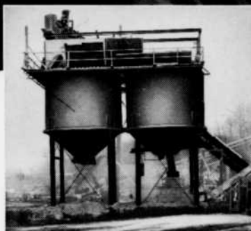
Deux trémies élevées à pierres à deux compartiments de 18 pi. 6 po. de diamètre par 32 pi. 3 po. (hauteur totale) construites et érigées par Horton pour George Campbell Co. Ltd., Fort Erie, Ontario.
