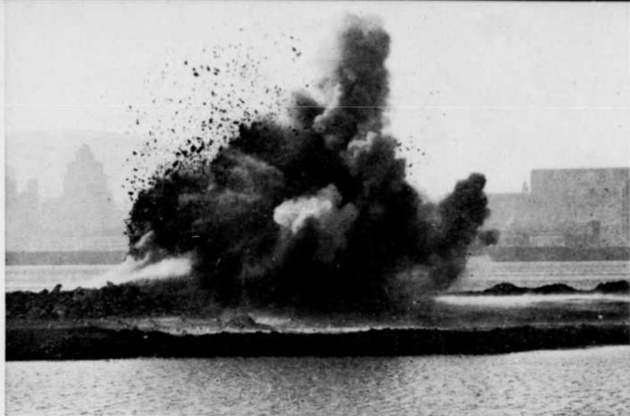
Le tir de 10,000 verges cubes de roc marque le début des travaux de construction de l'île Notre-Dame.
