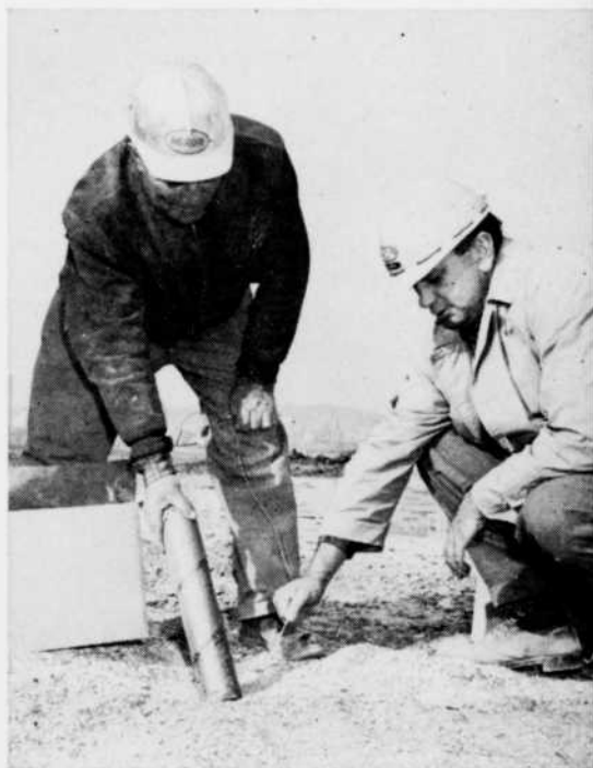
L'utilisation conjointe d'"Hydromex" M-2 et de "Forcite" 75% a permis l'agrandissement des plans de forage tout en procurant une bonne fragmentation et réduisant le coût au minimum.
