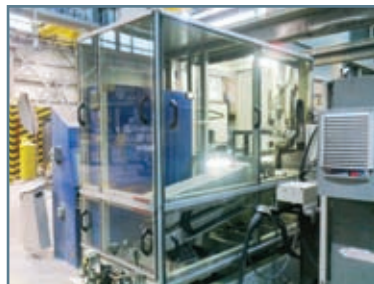
Vue de l'équipement suite à l'ajout des panneaux transparents en polycarbonate.
