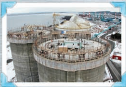
17 novembre 2003 - Rien n'arrête la construction; ni le froid, ni la hauteur des silos.
