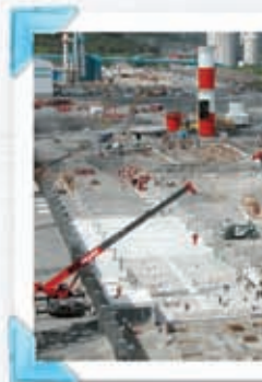
10 juillet 2003 - Les travaux et progressent bien.
