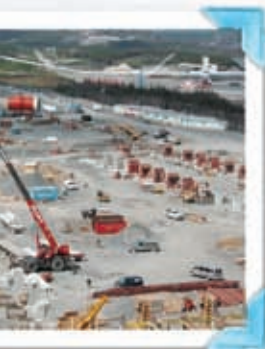
Les travaux débutent rapidement
