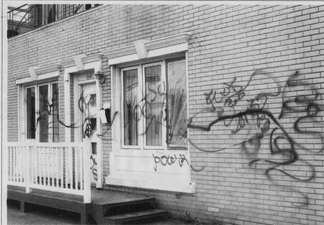
GRIFFE ! - Cet immeuble situé au 1043 de la rue Bagot dans l'arrondissement de La Baie a été la proie des vandales dans la nuit de samedi à dimanche. Selon le lieutenant Steeve Gilbert de la Sûreté municipale de Saguenay, ce n'est pas la première fois cette semaine que de tels actes sont perpétrés sur le territoire baieriverain. Les policiers enquêtent.
