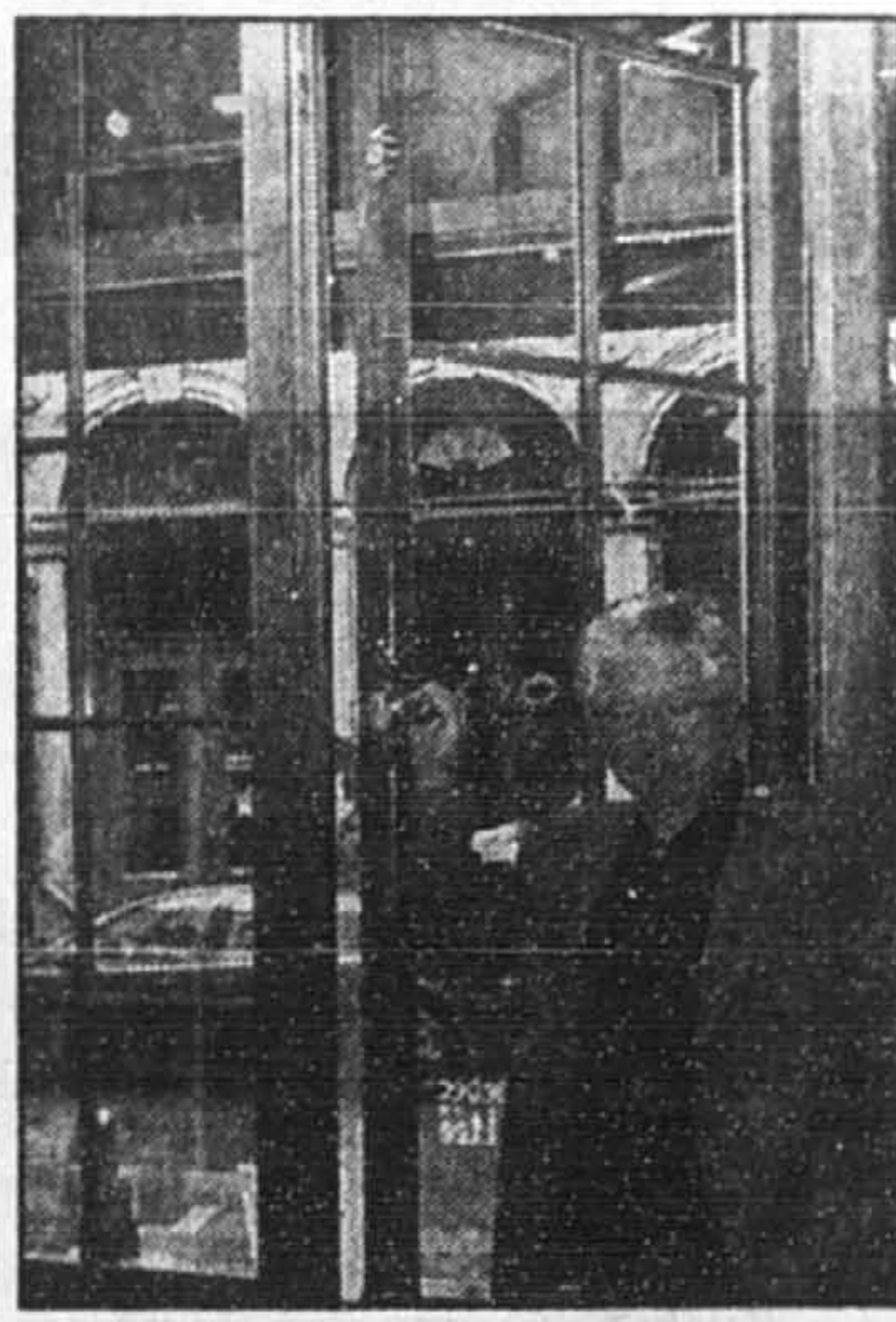
PHOTO RÉMI LEMÉE, La Presse Gilles Morin restaure des fenêtres rue Saint-Paul.
