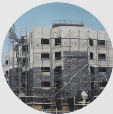
Résidence pour personnes âgées à Scarborough Une autre application de PERM•A•BARRIER
