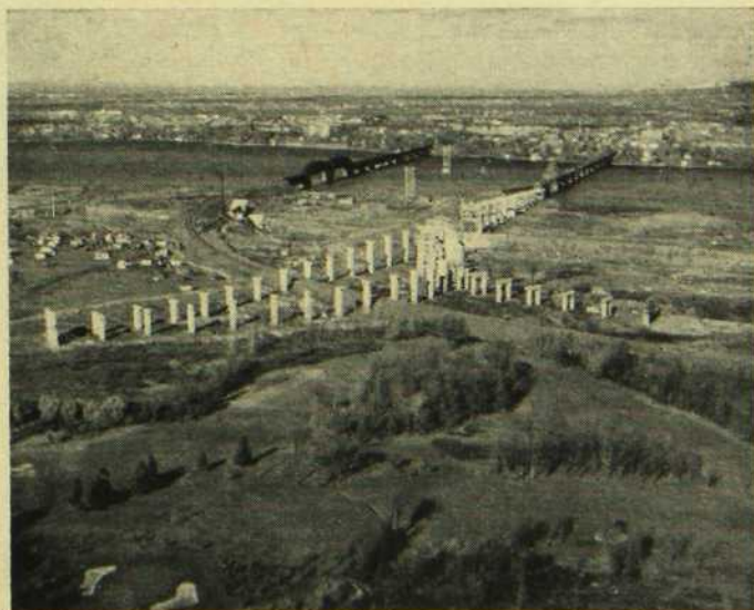
Construction d'un pont sur la rive sud du Saint-Laurent, nécessitée par la voie maritime.
