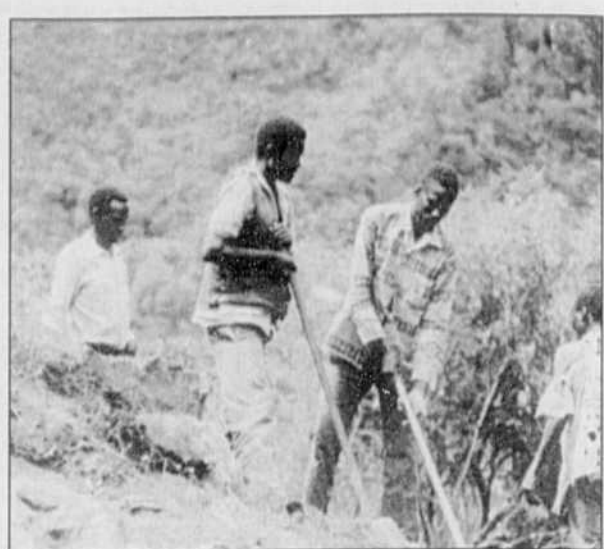
La faiblesse des infrastructures freine encore le développement de plusieurs pays. Ci-dessus: construction d'une route rurale au Kenya
