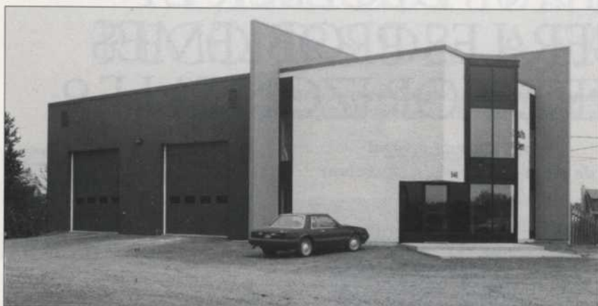
Édifice industriel/entrepôt de Explogestion, à Bernières
