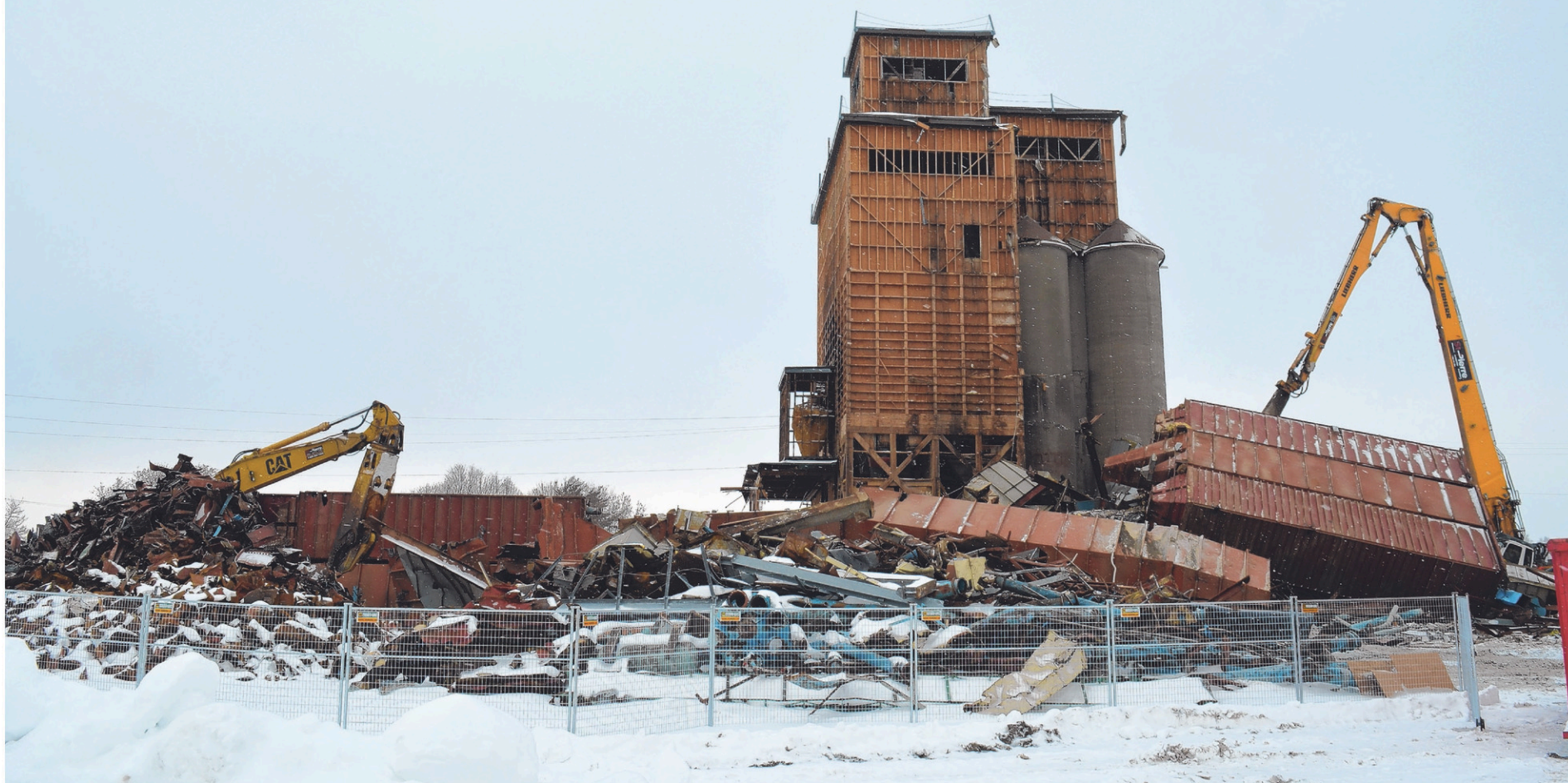
Les travaux de démolition de l'ancienne meunerie ont débuté en décembre et devraient être complétés à la fin avril. (Photos:GranbyExpress-Eric Patenaude)
