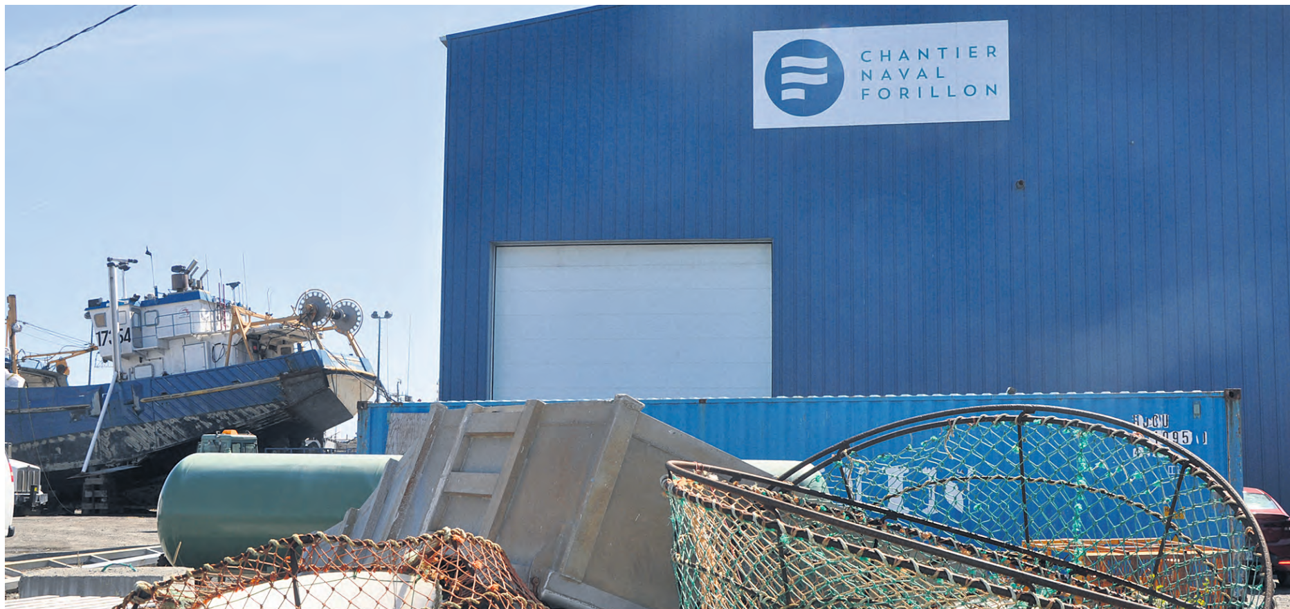
Les nouveaux lieux leur donnent 20 000 pieds carrés de plancher supplémentaires répartis en deux bâtiments principaux; l'un comprenant un entrepôt et un atelier de fabrication et de préassemblage, l'autre un hangar.
