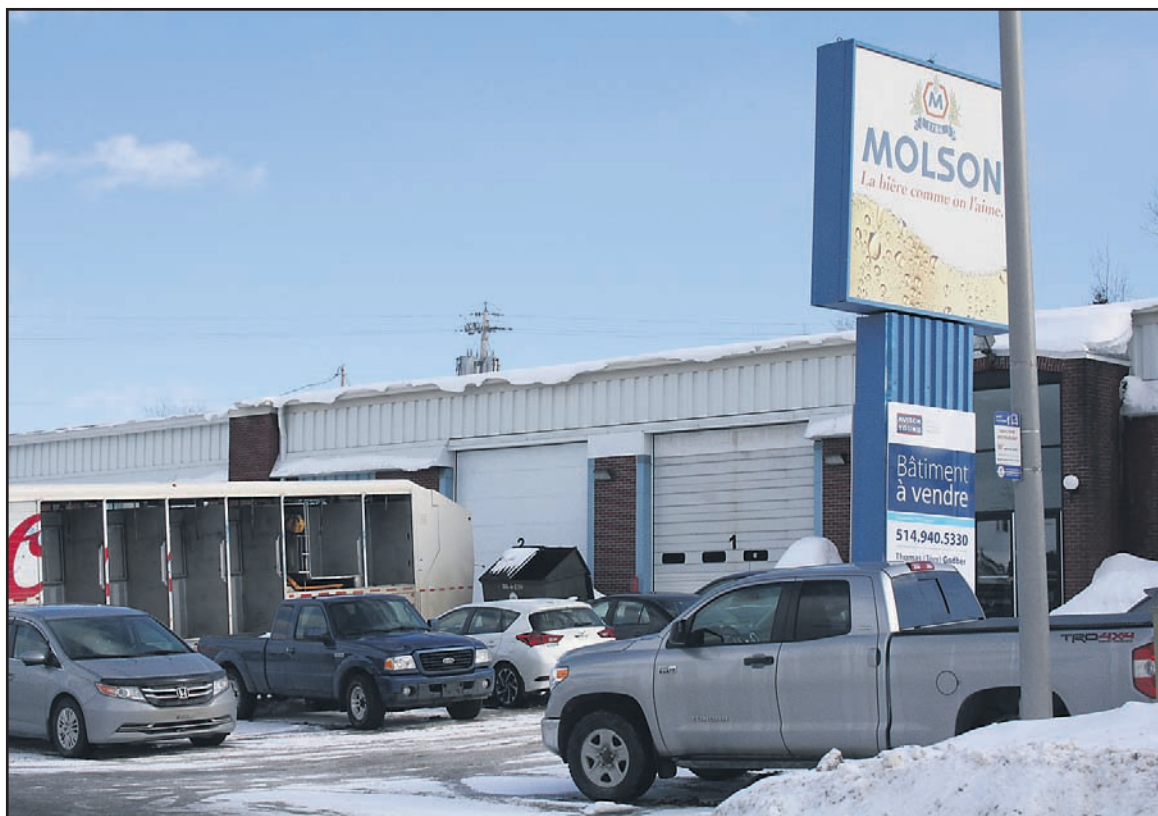
Tout laisse croire que la Ville de Baie-Comeau relociera bientôt sa caserne de pompiers du secteur est dans l'entrepôt de la brasserie Molson, rue Roméo-Vézina. Photo Le Manic
