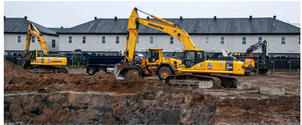
Photo : Maxime Labelle Lisez notre édition du 14 juin prochain pour avoir tous les détails de ce grand chantier.
