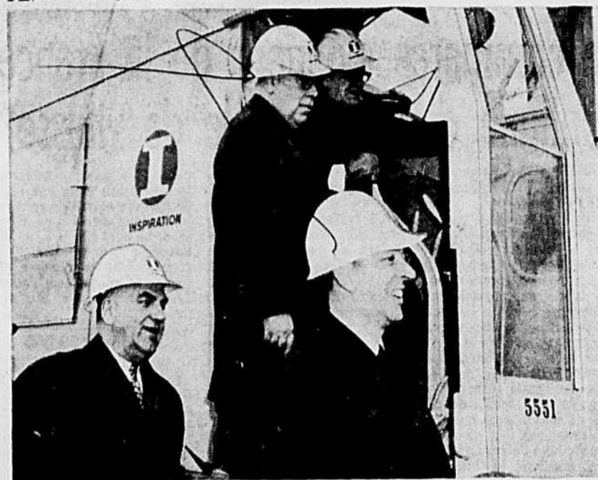
Commencement des travaux à l'hôpital Saint-Maurice
