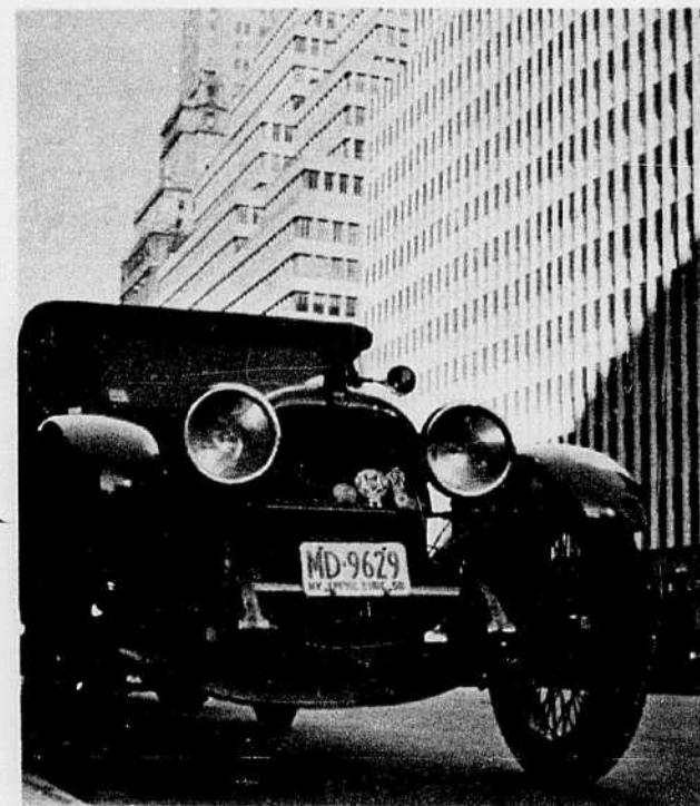
A droite, la façade de nouveaux édifices sur Park Avenue, à New-York. A gauche, une automobile de 1921 de marque Mercer. Quel contraste !
