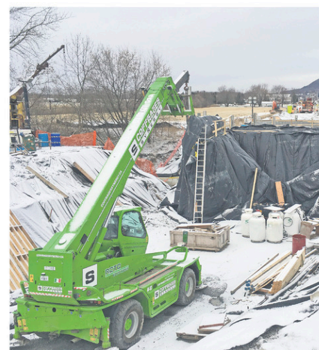
Chantier du pont Lacaille. Photo: Denis Bélanger
