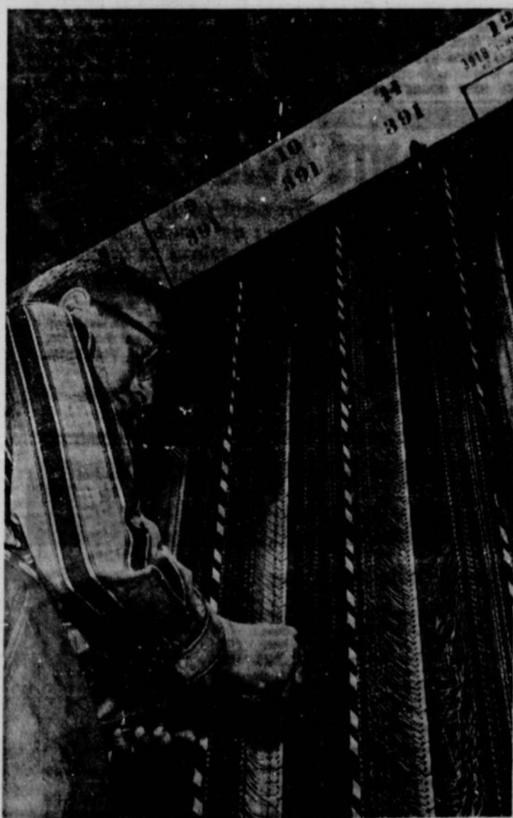
LES CABLES EN PROVENANCE de divers immeubles téléphoniques sont divisés en paires de fils dont chacune est identifiée sur les répartiteurs que l'on voit ci-dessus.
