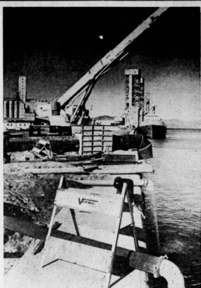
La pleine lune est en partie responsable de la violence des marées qui ont provoqué des infiltrations inhabituelles sous les quais.
