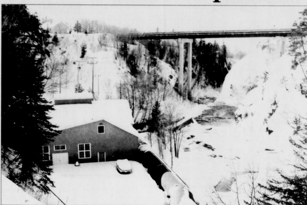
La plus ancienne centrale privée est située sur la rivière du Loup. Elle est en service depuis 14 ans.
