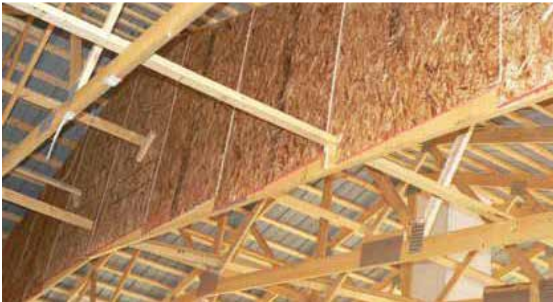
Exemple d'une compartimentation de vide sous toit (avant la pose du plafond) avec une séparation de panneaux d'aggloméré avant la pose du plafond.
