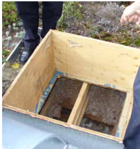
Ouverture dans le platelage d'un toit végétalisé, jumelée avec un col de cygne pour la ventilation du vide sous toit : projet pilote du Centre d'écologie urbaine de Montréal CÉUM), Coopérative de la Petite Cité, rue Jeanne-Mance, quartier Milton Park. PHOTOS : VILLE DE MONTRÉAL (H. CUONG NGUYEN)
