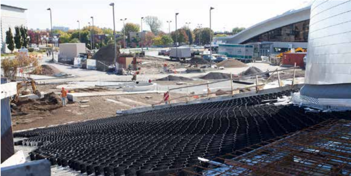
Dispositif antiglisement de la firme Hydrotech sur le toit végétalisé du Planétarium Rio Tinto Alcan de Montréal. Les alvéoles retiennent le substrat de croissance et la végétation. PHOTO : VILLE DE MONTRÉAL (BENOIT GARIÉPY)
