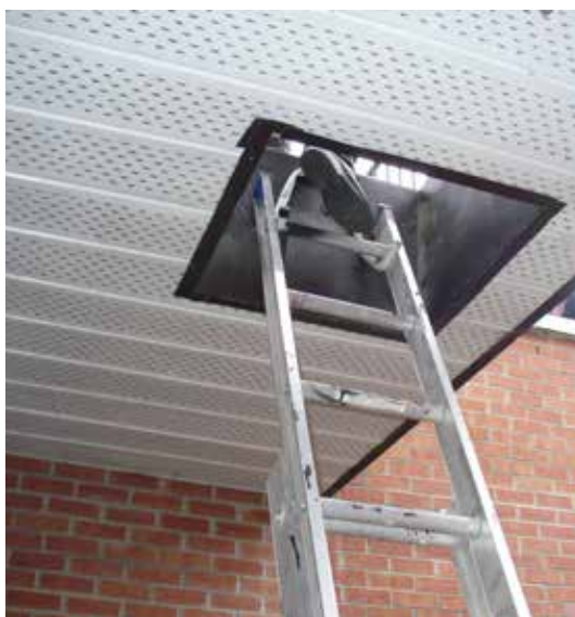
Accès réservé aux fins d'entretien d'un toit végétalisé. Une échelle peut être installée et retirée après usage pour limiter l'accès au toit à partir d'un balcon, comme c'est le cas ci-dessus. Projet pilote du Centre d'écologie urbaine, Coopérative de la Petite Cité, rue Jeanne-Mance, quartier Milton Park. PHOTOS VILLE DE MONTRÉAL (H. CUONG NGUYEN)
