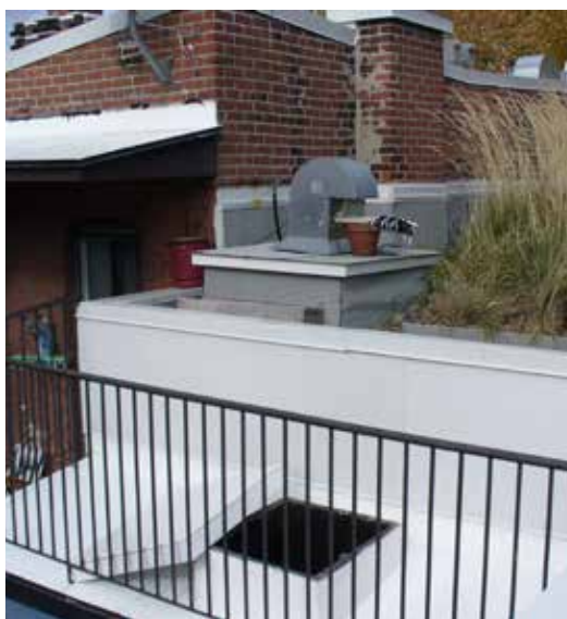
Accès réservé aux fins d'entretien d'un toit végétalisé. Une échelle peut être installée et retirée après usage pour limiter l'accès au toit à partir d'un balcon, comme c'est le cas ci-dessus. Projet pilote du Centre d'écologie urbaine, Coopérative de la Petite Cité, rue Jeanne-Mance, quartier Milton Park. PHOTOS VILLE DE MONTRÉAL (H. CUONG NGUYEN)
