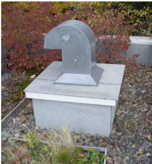
Ouverture dans le platelage d'un toit végétalisé, jumelée avec un col de cygne pour la ventilation du vide sous toit : projet pilote du Centre d'écologie urbaine de Montréal CÉUM), Coopérative de la Petite Cité, rue Jeanne-Mance, quartier Milton Park. PHOTOS : VILLE DE MONTRÉAL (H. CUONG NGUYEN)
