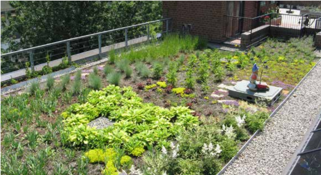
Un toit vert accessible au public avec son appentis d'escalier, son observatoire, ses pergolas et ses garde-corps au pourtour du toit – Maison de la culture Côte-des-Neiges. PHOTO : VILLE DE MONTRÉAL (BENOIT GARIÉPY)
