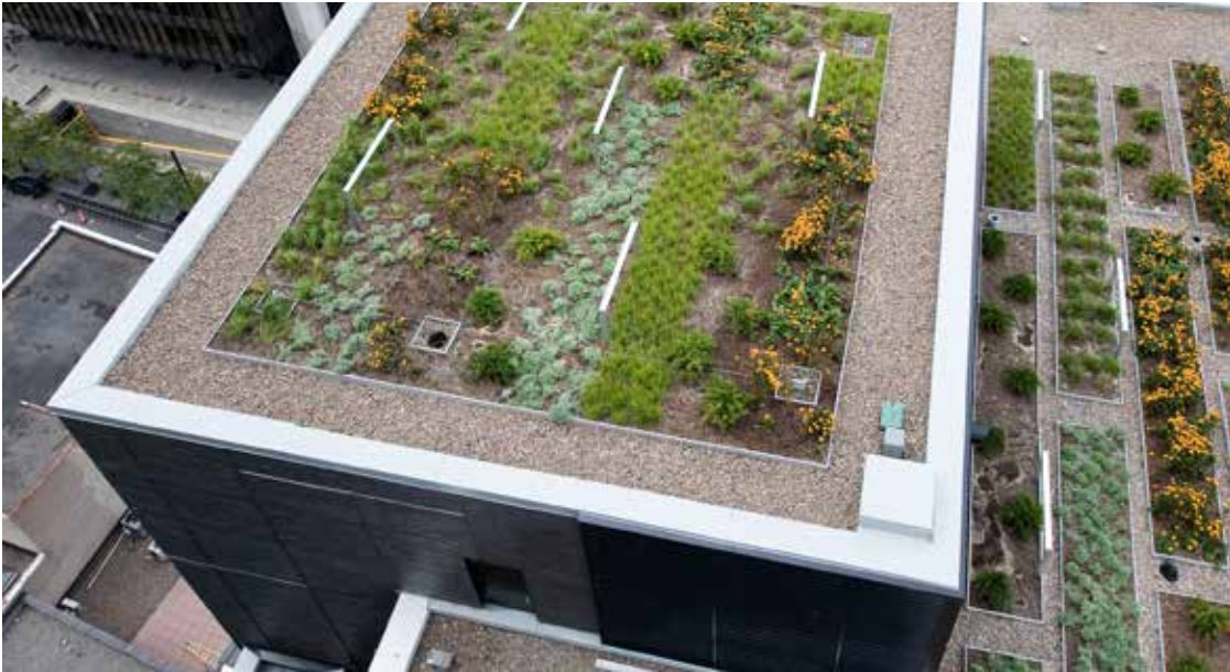
Toit végétalisé « extensif » sur le toit du siège social de Québecor (rue Saint-Jacques) à Montréal.
