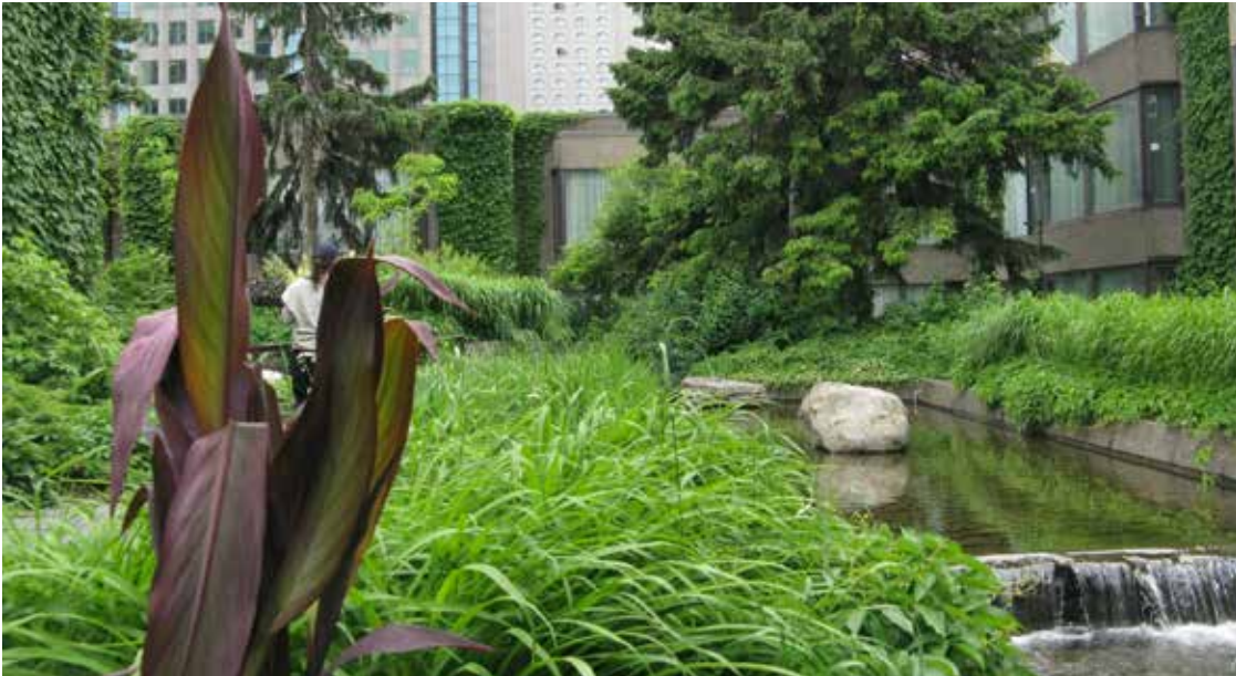
Le premier toit-terrasse végétalisé au Canada, avec ses canaux, ses chutes et sa piscine : l'Hôtel Bonaventure construit en 1967. Un toit végétalisé qu'on qualifierait aujourd'hui de toit végétalisé « intensif » aménagé sur un bâtiment de béton (incombustible). PHOTO : VILLE DE MONTRÉAL (BENOIT GARIÉPY)
