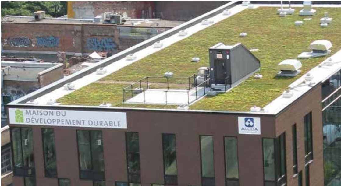
Maison du développement durable : toit végétalisé extensif PHOTO : VILLE DE MONTRÉAL (BENOIT GARIÉPY)
