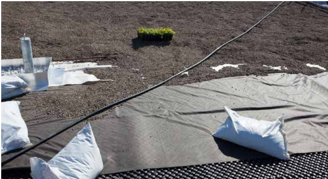
Matériaux et quelques-unes des couches entrant dans la composition d'un toit végétalisé – Maison de la culture Côtés-des-Neiges. PHOTO : VILLE DE MONTRÉAL (BENOIT GARIÉPY)
