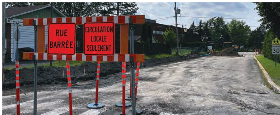
Des travaux se déroulent sur la rue de la Chanterelle, à Saint-Basile-le-Grand. (Photo : Frank Jr Rodi)
