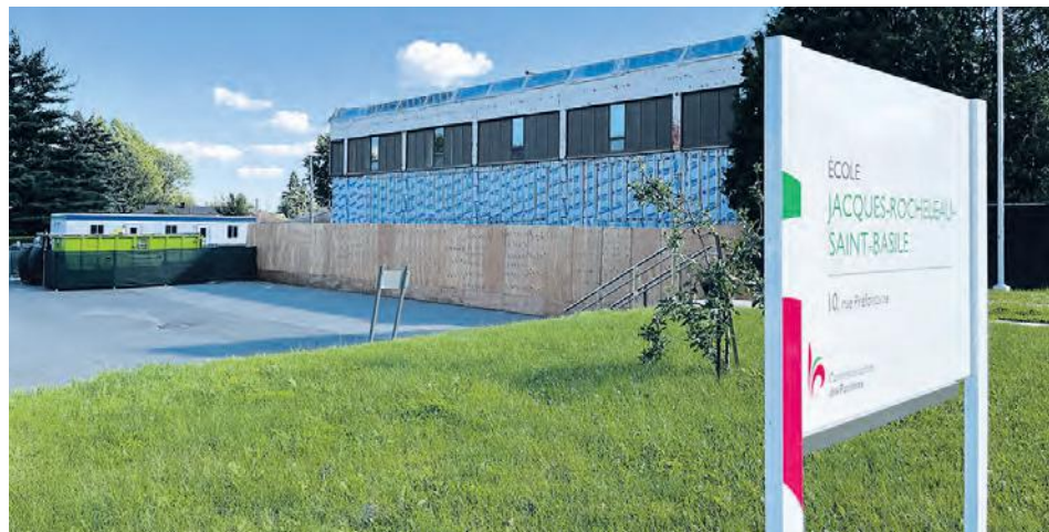
Des travaux ont eu lieu à l'école Jacques-Rochelleau au cours des derniers mois. (Photo : Frank Jr Rodi)
