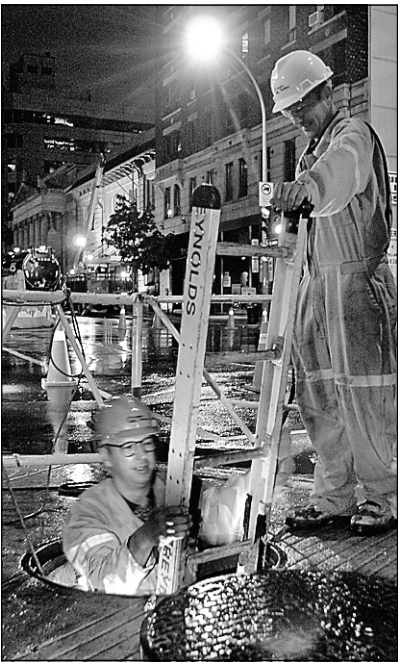
PHOTO MARTIN TREMBLAY, LA PRESSE Les jointeurs d'Hydro-Québec au travail durant la nuit, dans le sous-sol du centre-ville de Montréal.
