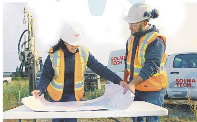
Contrôle de chantier – Photo: Solmatech
