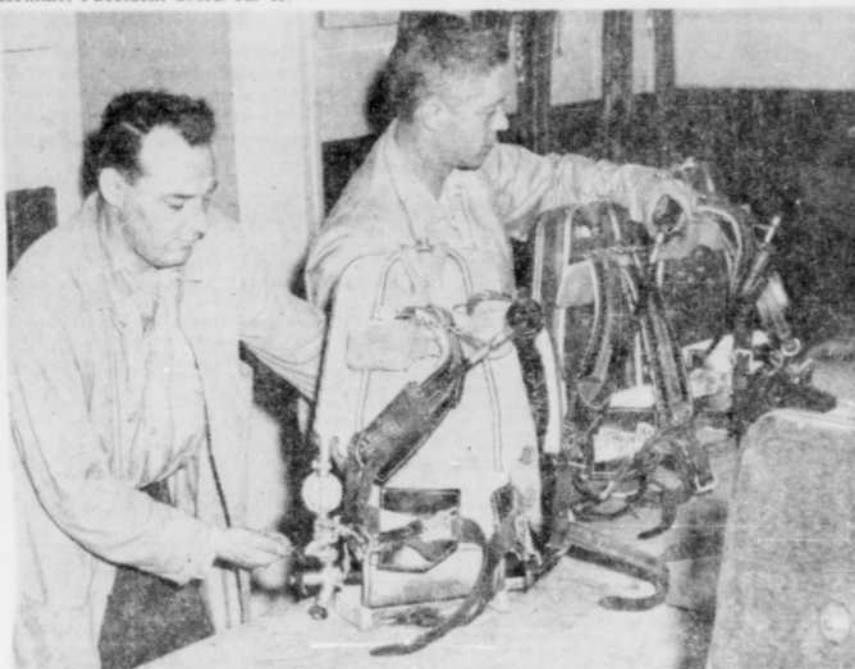
Vérification des appareils. — Avant de servir aux concurrents du concours provincial des mines qui s'est tenu à Asbestos en fin de semaine, les appareils respiratoires ont été soigneusement vérifiés par MM. Wilbrod St-Laurent, à gauche, et Réginald Houde, à droite, surintendant de poste de sauvetage respectivement de Noranda et des Cantons de l'Est.
