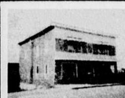
124 rue d'Amours Edifice commercial
