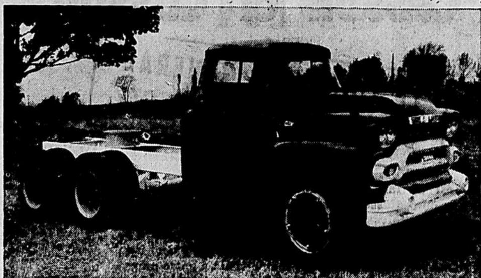
General Motors of Canada, Limited annonce la sortie de nouveaux camions GMC ultra-puissants à moteurs améliorés, devant d'allure massive et châssis renforcés. Neuf modèles nouveaux portent à 76 le nombre des camions GMC construits au Canada. Ci-dessus nous voyons un modèle de la série tandem 91,000 et dont la capacité est de 50,000 livres.
