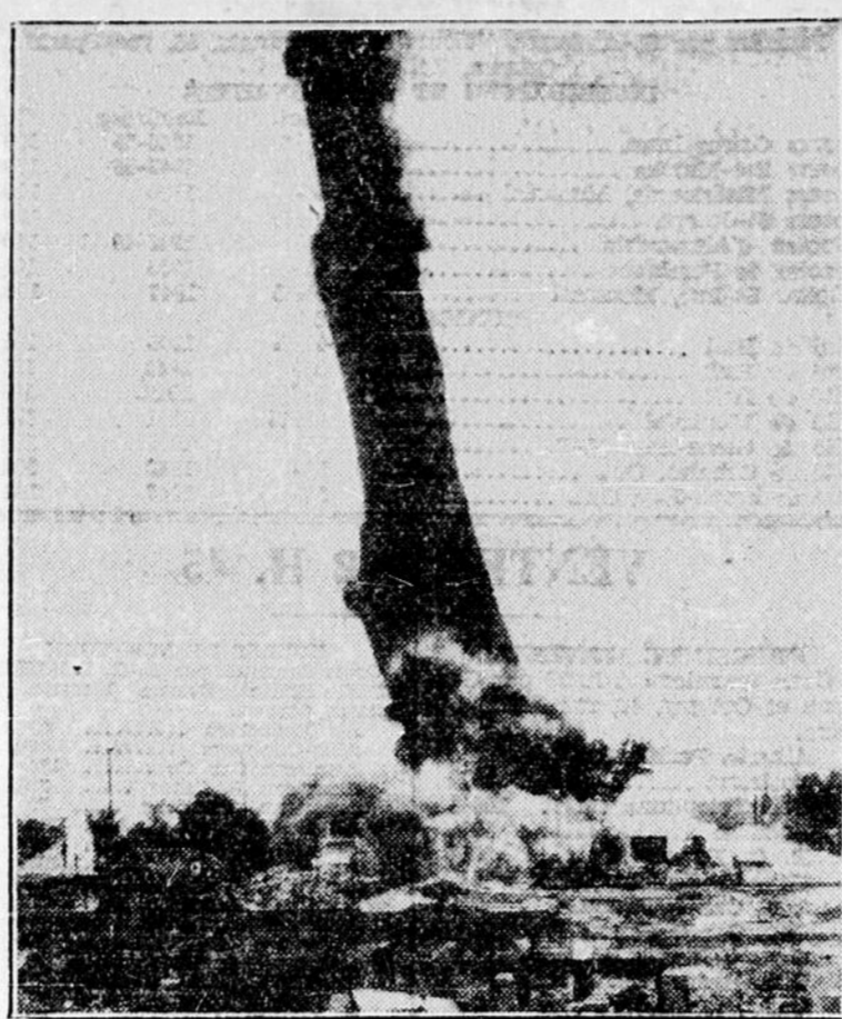
Des ouvriers qui travaillaient aux fondations de cette vieille cheminée à Lovell, Mass., furent obligés de se sauver en vitesse quand cette masse de brique d'une hauteur de 200 commença à s'écrouler.
