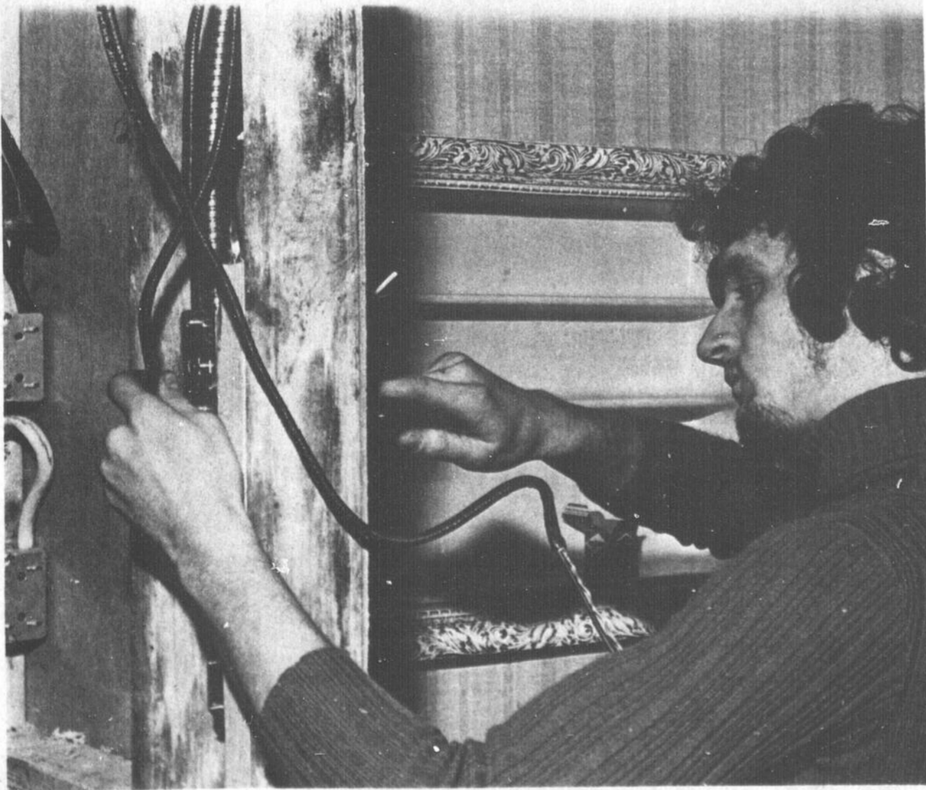
SYSTEME ELECTRIQUE — Un électricien de Norab effectue un raccord dans la chambre de bains d'une maison mobile.
