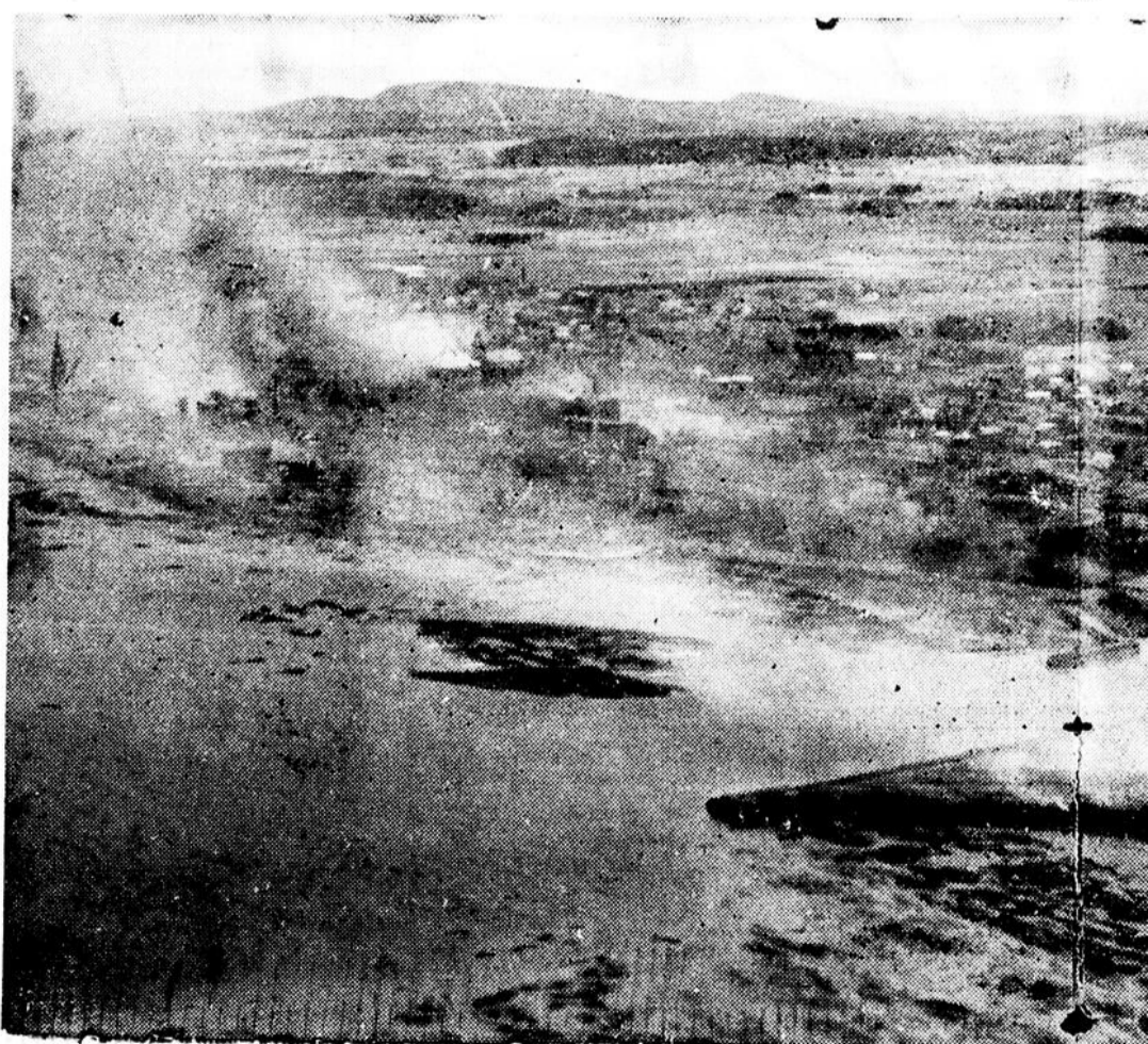
Autre vue aérienne de Rimouski, que les flammes
