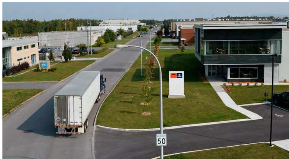
La Ville entreprend l'agrandissement de son parc industriel. (Photo : archives)
