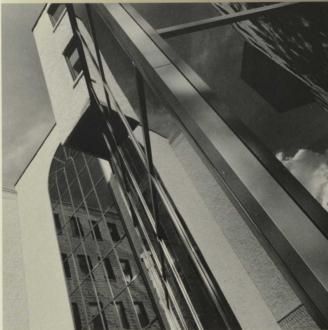
COLLÈGE VANIER, VILLE SAINT-LAURENT — PATRICE POIRIER ARCHITECTE : (514) 493-6000
