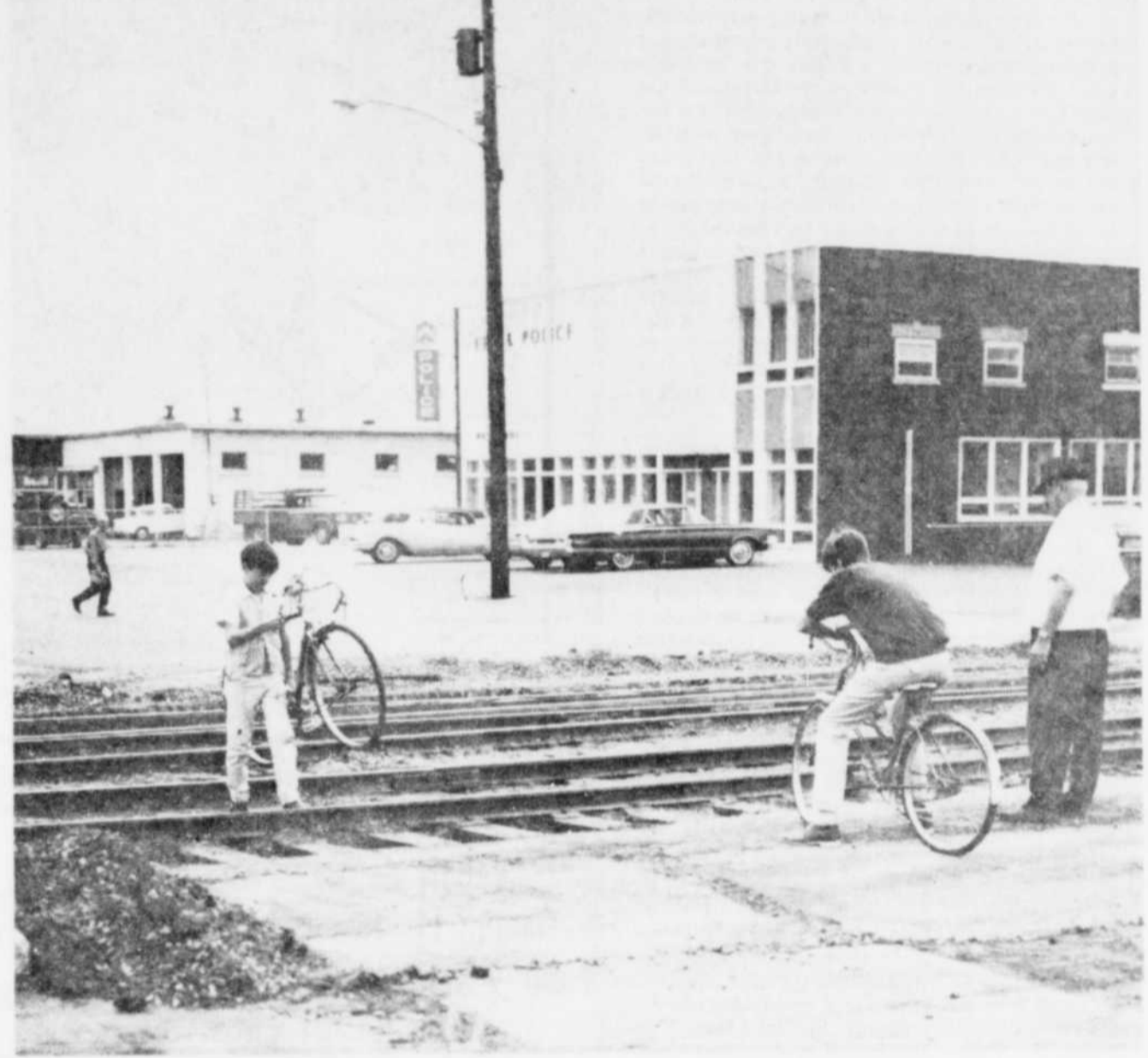
LA CIRCULATION est momentanément détournée sur le boulevard Royal à Trois-Rivières, près du poste de police no 1, alors qu'on est à compléter des travaux de refecton du revêtement d'asphalte franchissant les voies ferrées du Pacifique Canadien. Nul doute que ces travaux s'imposaient depuis longtemps, parce que ce passage à niveau était vraiment en piteux état.
