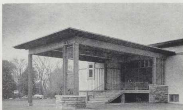
Détail du porche de l'entrée principale, face à la route de Ste-Dorothée. Composition de bois et de treillis de fer, base de pierre.
